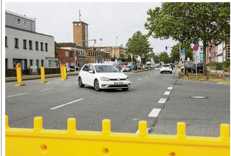
Seit Montag ist die Dieselstraße in Höhe der Wolfsburger Berufsfeuerwehr gesperrt. Vor der Einfahrt staut sich der Verkehr.
