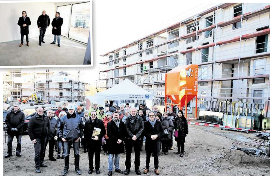
Wohnen am Salzteich: VW Immobilien und LIST Bau stellten das Projekt vor. Der Vertrieb für die drei Mehrfamilienhäuser hat begonnen.
